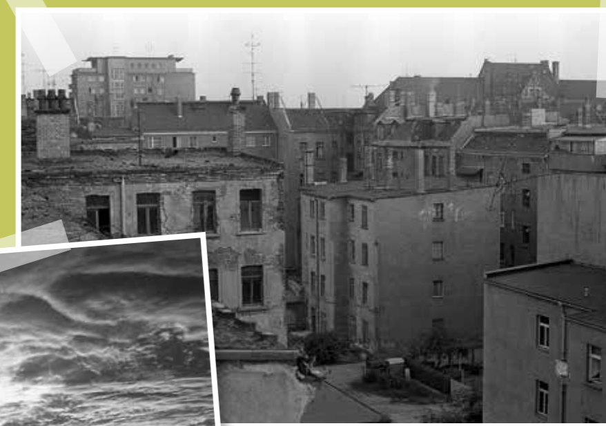
Schornsteine auf den Dächern: Leipzig bot die typische „Skyline“ einer mit Kohle beheizten Stadt in der DDR.
