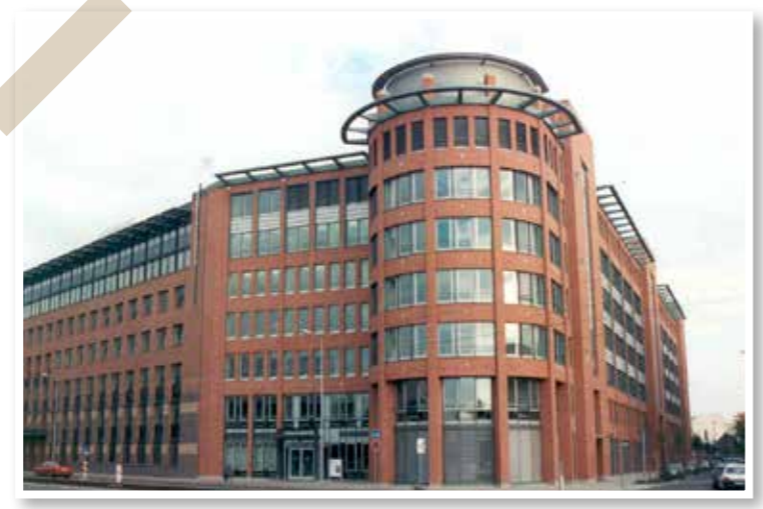
Fast 20 Jahre lang war die LWB Mieterin des Bürohauses in der Prager Straße 21.
