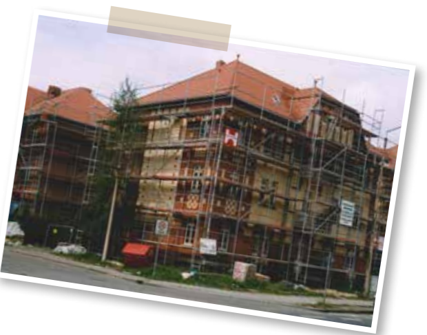
Die Gartenstadt in Alt-Lößnig wurde von März 1998 bis November 1999 saniert. In den Erhalt und die Modernisierung der 140 Häuser 802 Wohnungen flossen 130 Millionen DM. Die Kulturstiftung Leipzig würdigte das vorbildliche Engagement der LWB mit dem Hieronymus-Lotter-Preis für Denkmalpflege 1999.
