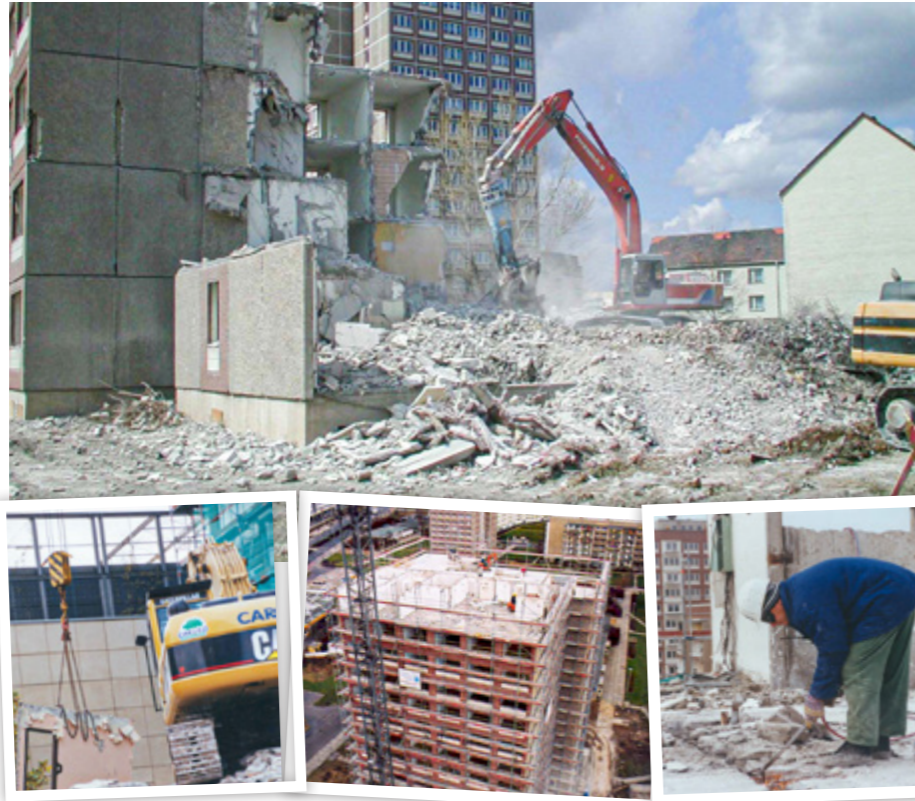
In der Garskestraße in Leipzig-Grünau hat die LWB ihre erste Platte abgebrochen. Der letzte Rückbau fand 2015 im WK 5.1 statt.
