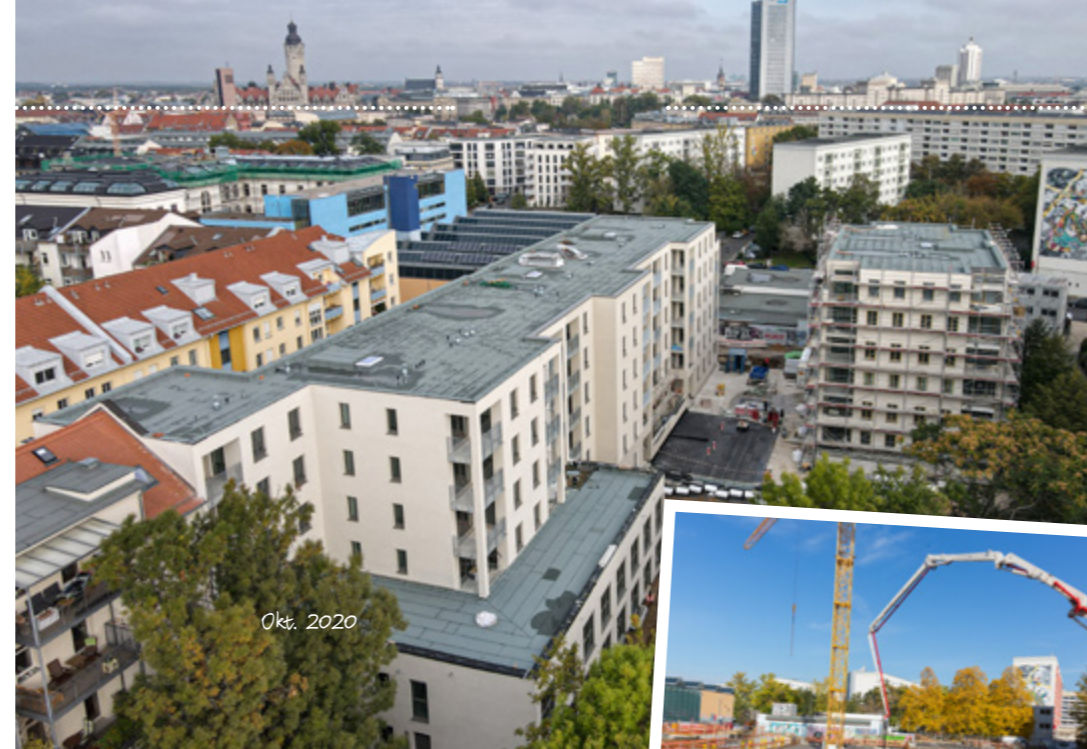
Die Bernhard-Göring-Straße wuchs in zwölf Monaten um sechs Etagen.
