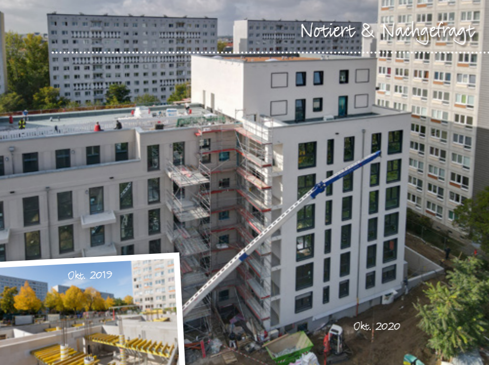
Die Straße des 18. Oktober 5-7 im Oktober 2020 (gr. Foto) und bei Kellerarbeiten im Oktober ein Jahr zuvor (kl. Foto).
