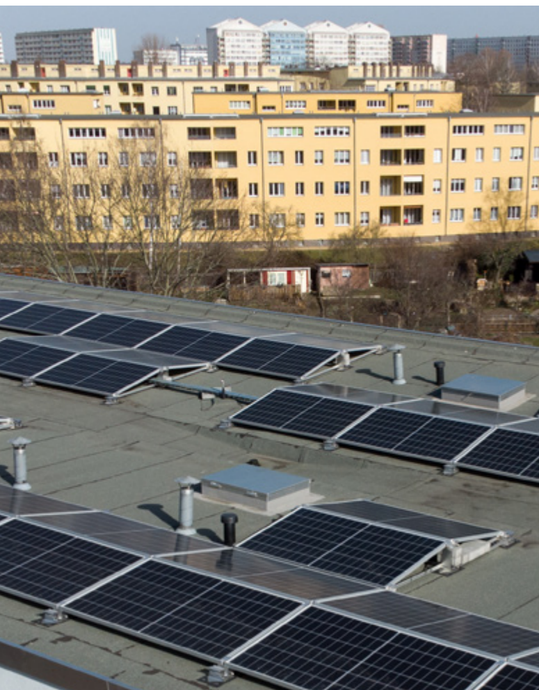
Photovoltaikanlagen auf Flachdächern in Dölitz (li.) und Paunsdorf: In diesen Stadtteilen werden im Herbst 2021 neue Module für Anlagen mit einer Gesamtleistung von 500 kWp installiert.
