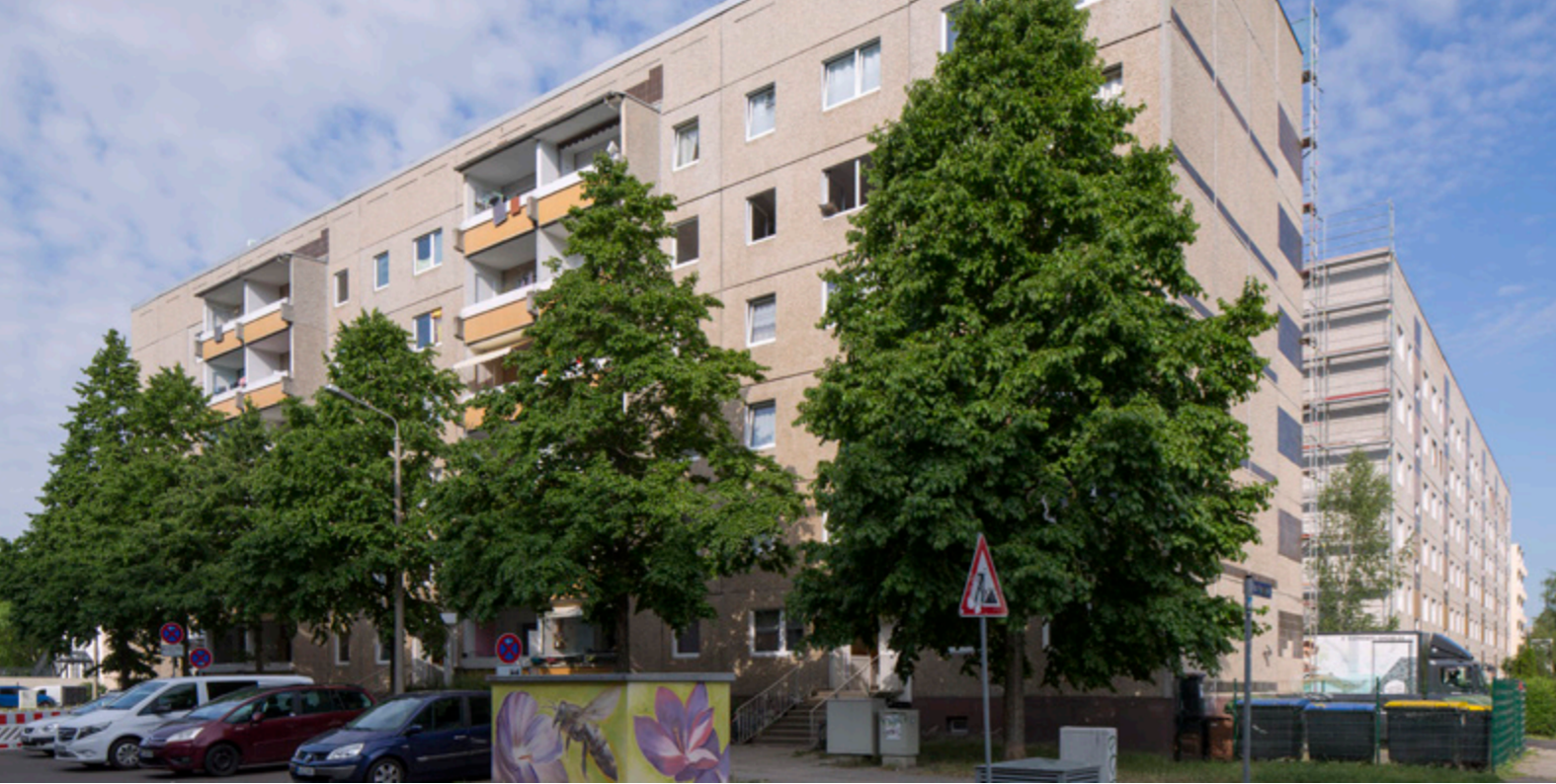
Paunsdorf: In dem nordöstlichen Plattenbauquartier Am Vorwerk 2-12/Gundermannstraße 21-31 saniert die LWB derzeit ihre Häuser.
