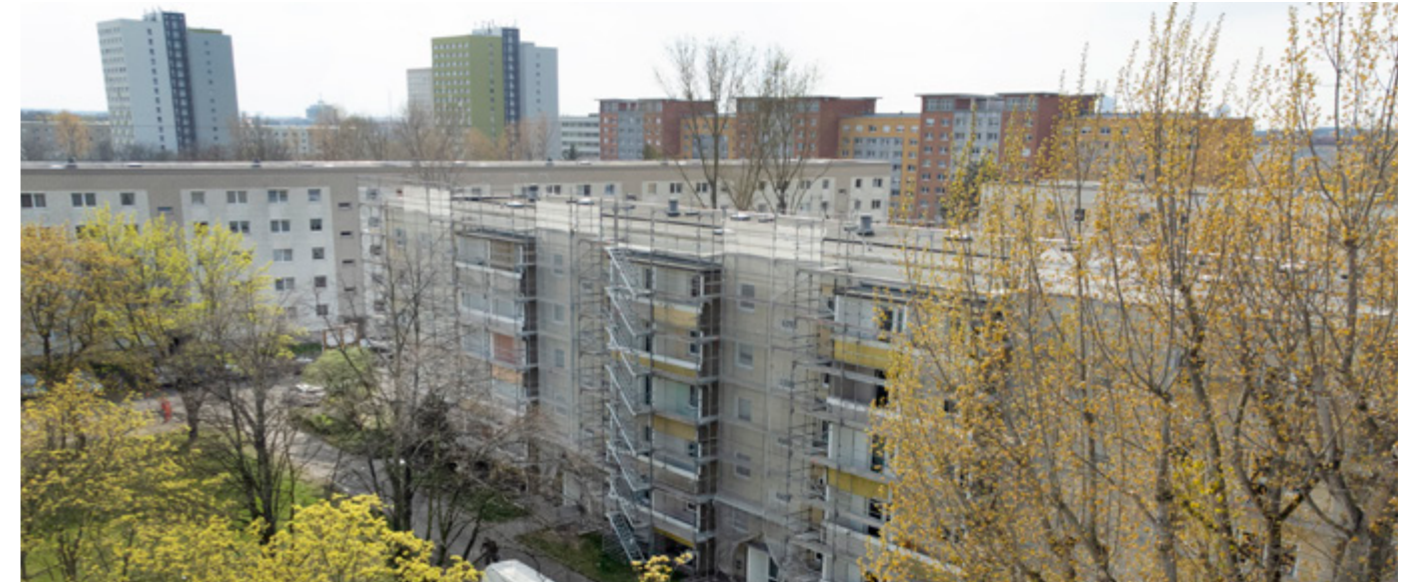
Schönefeld: In der Belterstraße 2-16 haben die Arbeiten begonnen. Sowohl im Inneren als auch an der Außenhaut finden umfangreiche Arbeiten statt.
