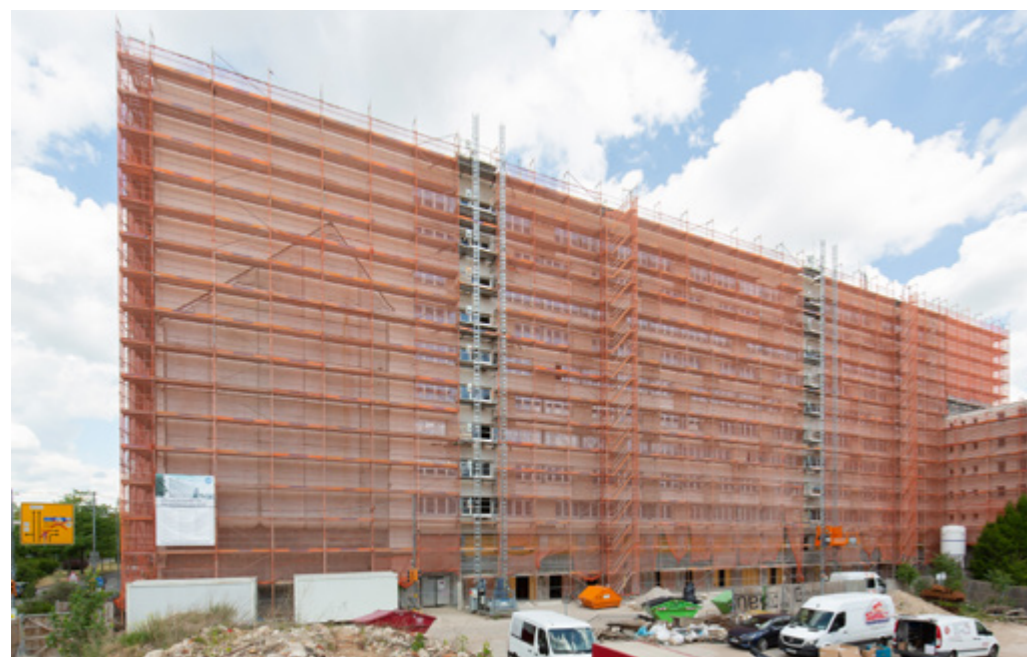
Zentrum: Die Gerberstraße 14-16 ist derzeit die größte Sanierungsbaustelle der LWB. Im kommenden Jahr soll alles fertig sein und die neuen Mieter können einziehen.
