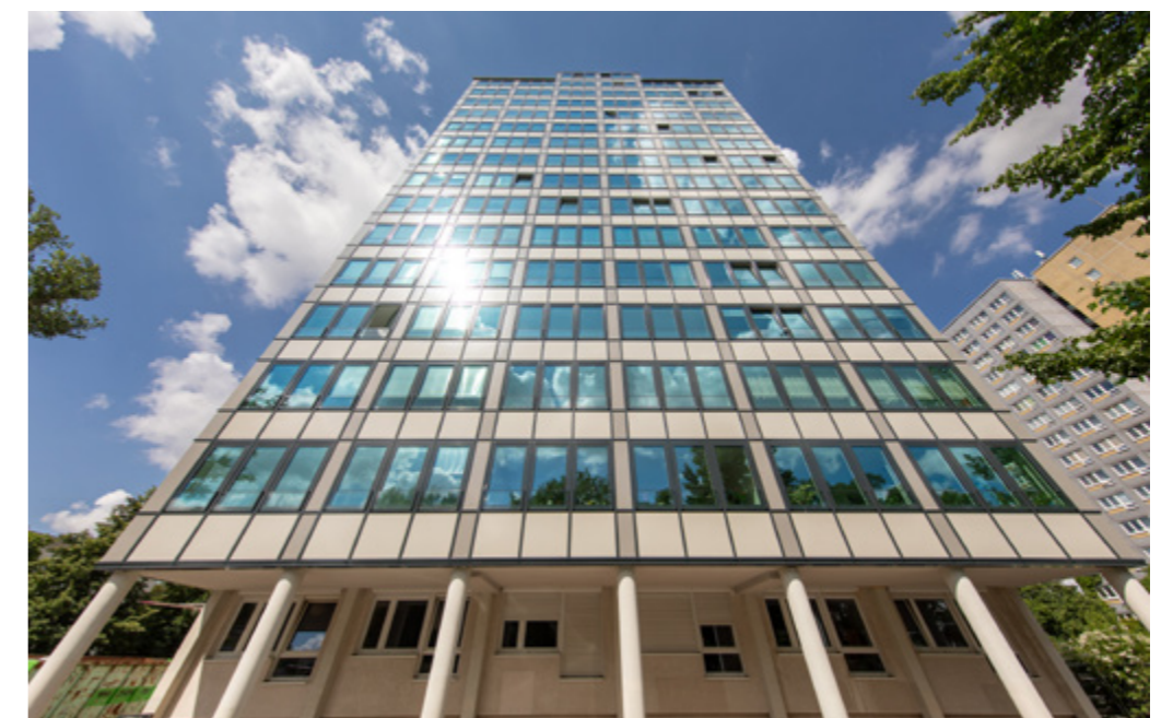
Schönefeld: In der Bästleinstraße 10 wird seit 2021 saniert. Schwerpunkt bilden hier die Arbeiten an der Fassade mit ihren verglasten und beheizten Balkonzimmern.
