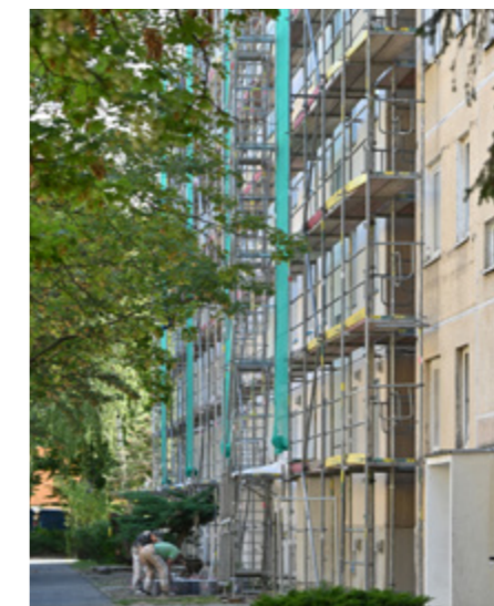
Auch im Seipelweg in Schönefeld laufen derzeit Sanierungsarbeiten.
