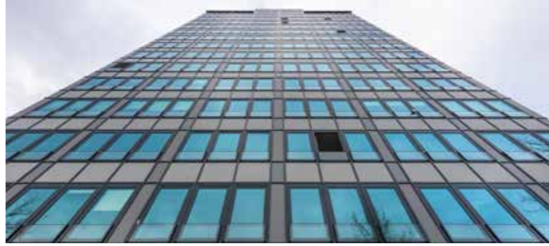
Bästleinstraße 10: Der 16-Geschosser wird bis 2023 umfassend saniert.
