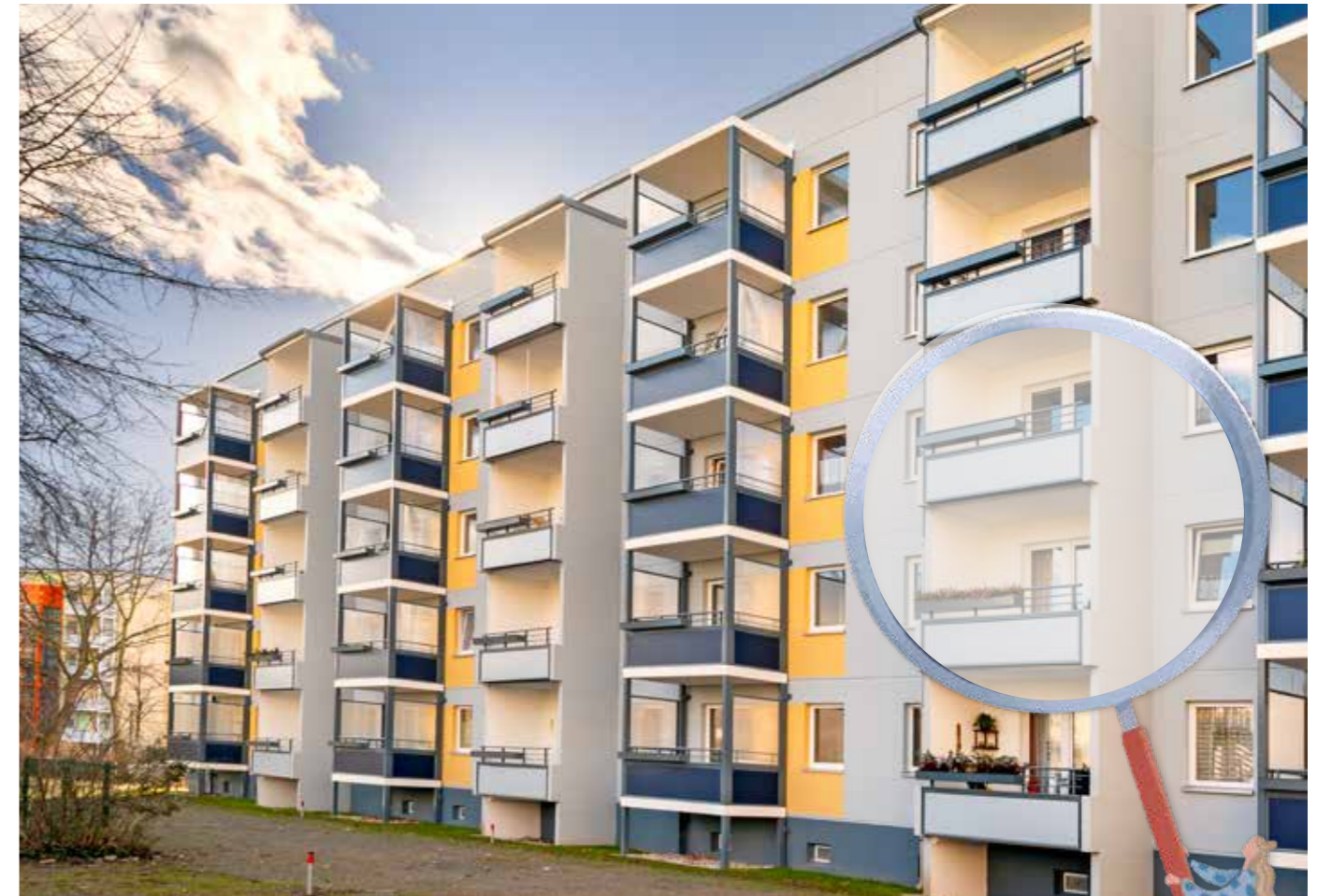
Neue Wärmedämmung und neue Fenster sind Teil der energetischen Sanierung in der Gersterstraße.
