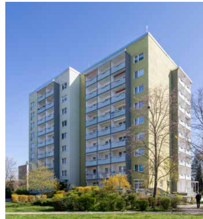
Im Titaniaweg 9 fanden umfangreiche Sanierungsarbeiten statt.
