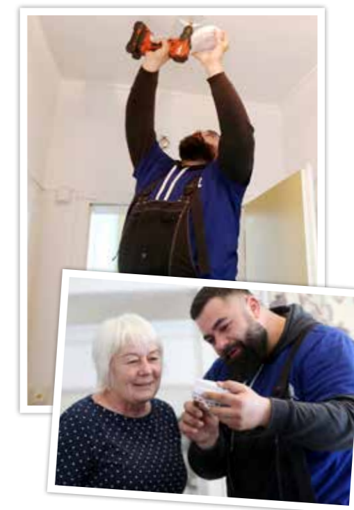
Die Messtechniker montieren die Rauchwarnmelder, prüfen vor Ort die Funktion und erklären den Mietern das Gerät.
